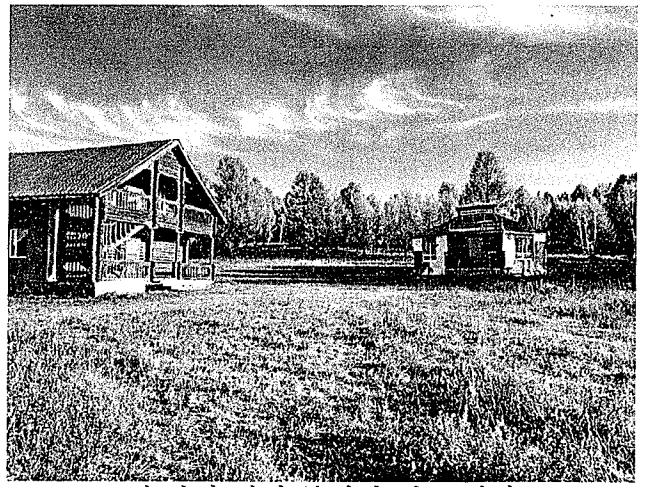
수련회 센터 부지와 건물 전경
